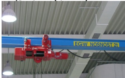
Obr.1. Jednonosníkový mostový jeřáb s podvěsným elektrickým kladkostrojem
