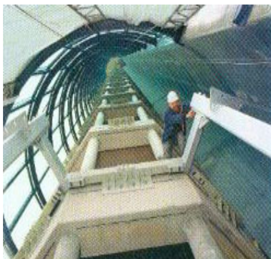
Obr.2. Pohľad do výťahovej šachty
