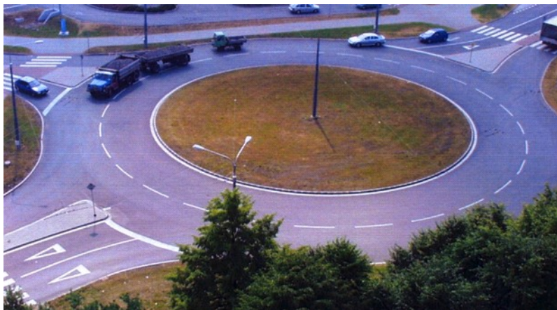
Obr. 2. Okružní křižovatka s dvoupruhovým okružním jízdním pásem (Ostrava, u obchodního centra Futurum – v současné době je již však tato křižovatka upravena jako jednoprhová)
