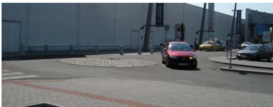
Obr. 3. Mini okružní křižovatka (na tomto příkladu z Karviné, u Hypernovy, je vidět chybná jízda osobního automobilu)
