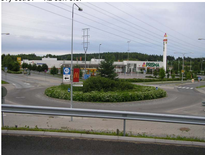
Obr. 3.1. Okružní křižovatka s částečně pojížděným ostrůvkem (Jyväskylä, Finsko)
