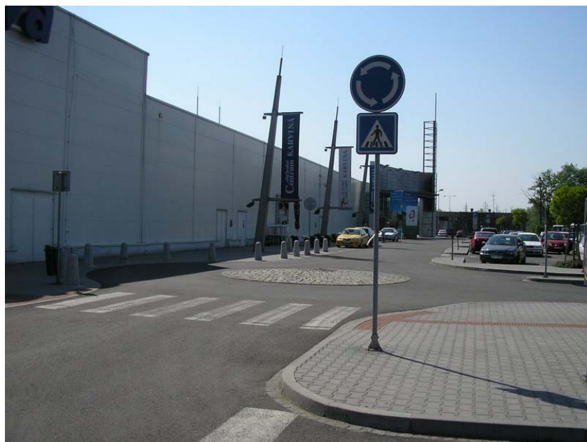
Obr. 3.2. Mini okružní křižovatka s plně pojížděným ostrůvkem (Karviná)
